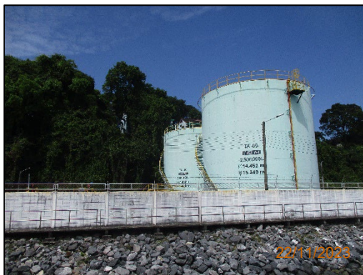
ภาพที่ 2-1 ถังเก็บน้ำมันสำรองประเภท Floating Roofs
