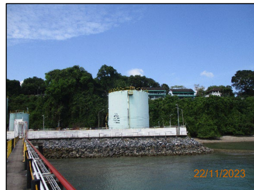
ภาพที่ 2-1 ถังเก็บน้ำมันสำรองประเภท Floating Roofs
